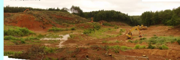
地方道(整備前)
