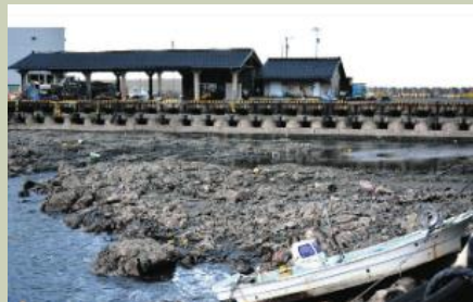
海底隆起・漁港機能の喪失
