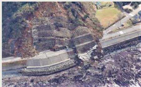
幹線道路の通行止め
