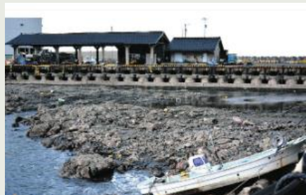
海底隆起・漁港機能の喪失
