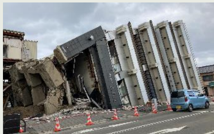
高層ビルの倒壊
