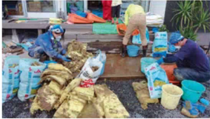
↑ 断热材の取出し
