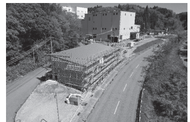
▲現在建設中の資源化物貯留棟と工場棟
