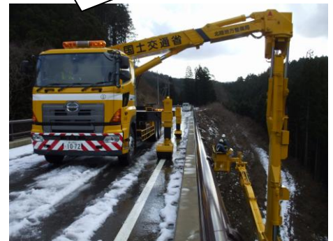
橋梁点検車による定期点検風景
