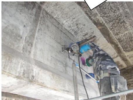
詳細調査の風景（広和橋）
