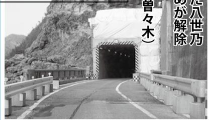
集落を孤立させた巨岩と土砂は除去され、崩れた斜面は擁壁整備された。
