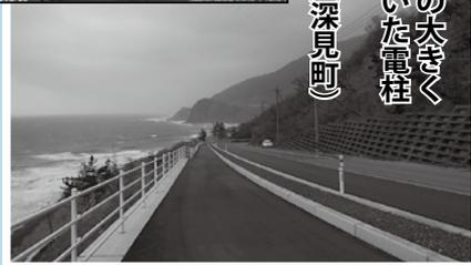
道を塞いだ土砂は除去され、崩れた斜面は擁壁整備された。
