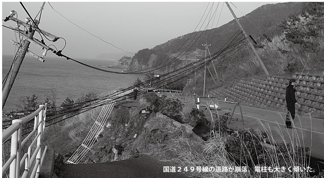
国道249号線の道路が崩落、電柱も大きく傾いた。
