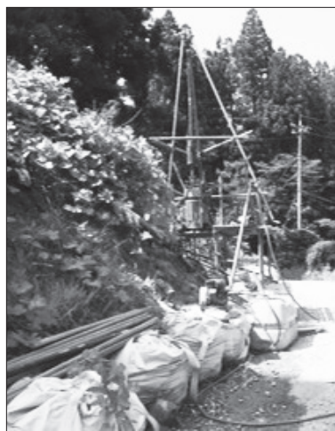
▲ボーリング調査の様子
