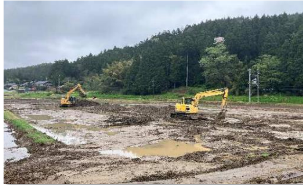
堆積土砂を除去中の農地（下黒川町）
