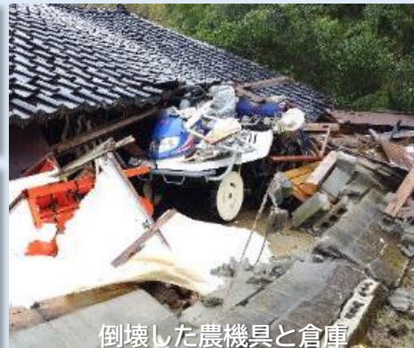
倒壊した農機具と倉庫
