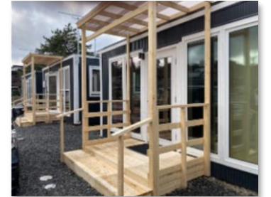
仮設店舗（観音町）
